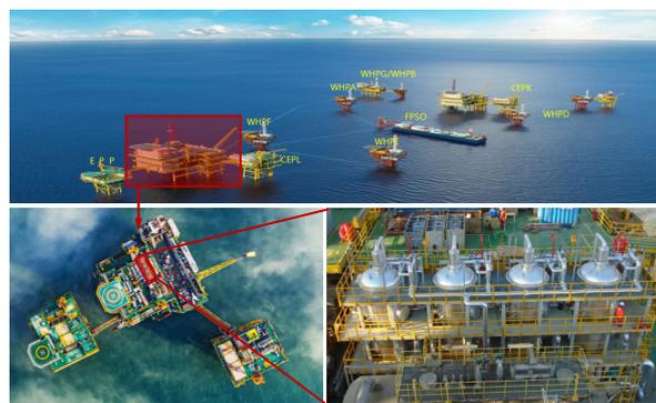
注：WHP即井口平台 (Wellhead Platform)，CEP即中心平台 (central equipment platform)，FPSO即浮式生产储油船 (floating production storage and offloading)，EPP即岸电平台 (electric power platform)，后续字母为标号。
