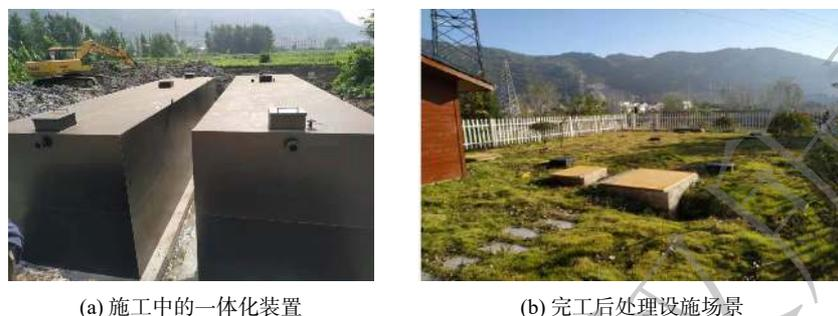
图 2 改良型 UCT 工艺一体化污水处理设施现场
