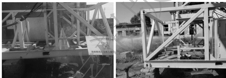
图 2 设备钻进实验现场
