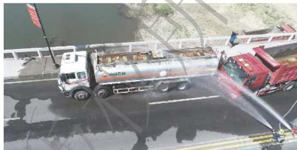
图6 油罐洒水降温及封堵现场
