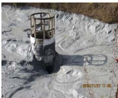
图1 尾矿库2#排水井破损现场照片
