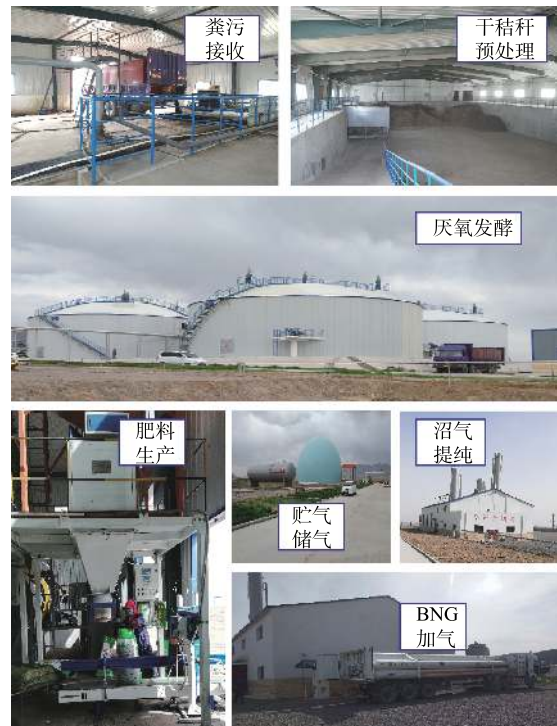
图4 生产现场 Fig. 4 Production work site
