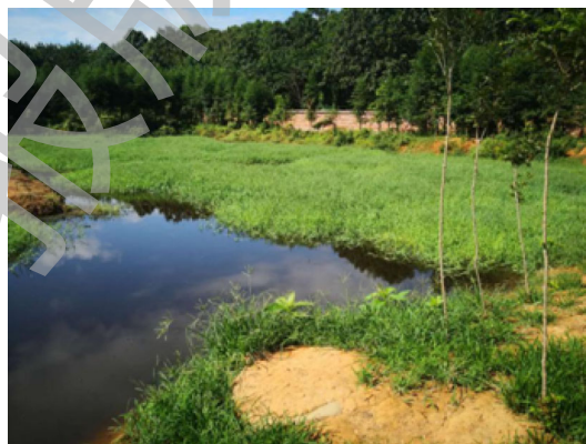
图2 微生物膜和双穗雀稗组成的生物强化控氮稳定塘
